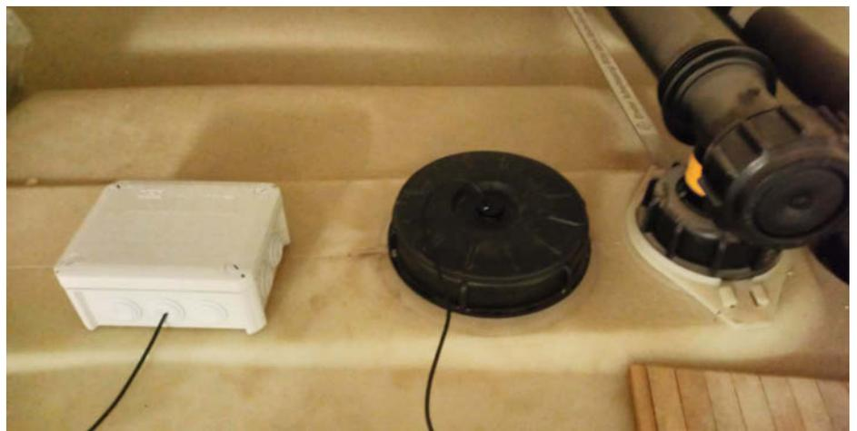
Der fertig eingebaute Sensor im Deckel des Heizöltanks
