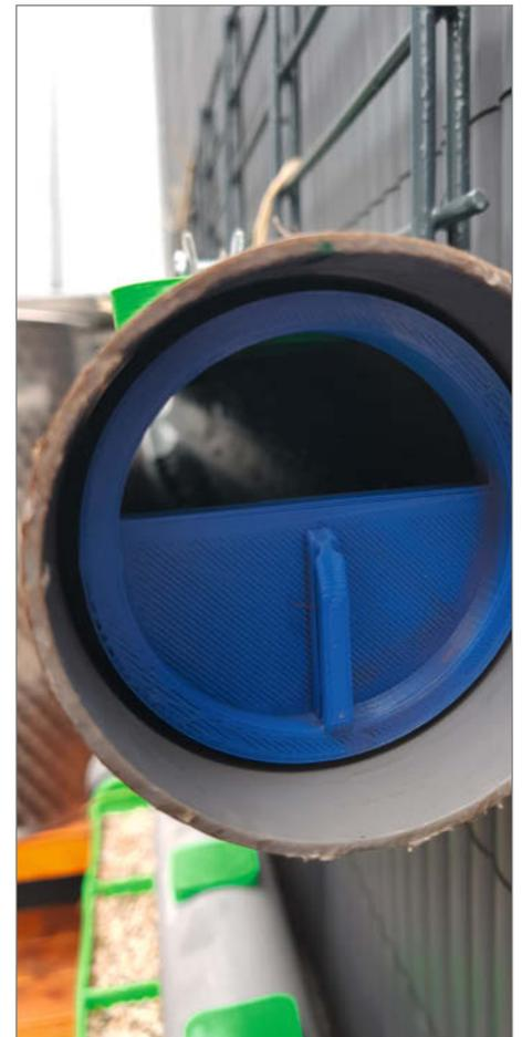
Eingesetzter Wasserstandsbegrenzer im HT-Rohr: Der Flüssigkeitsspiegel wird durch Drehen des Begrenzers eingestellt.
