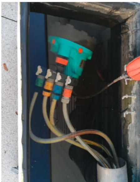
Pumpe mit Verteiler, pro Säule ein Schlauch
