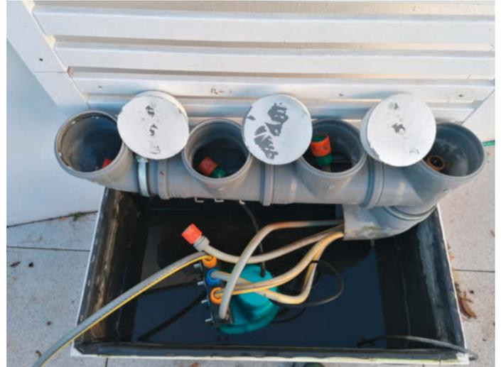
Schlauchkupplungen zum Aufstecken der Bewässerungsrohre in den Säulen
