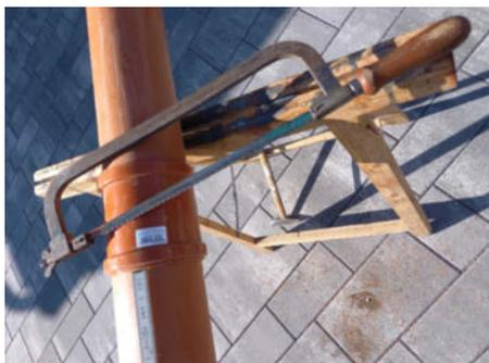
Mit einer Muffe als Schiene werden die Schnitte perfekt.
