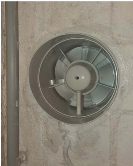
**15** Eingebautes Lüftungsrohr mit innenliegendem Ventilator
