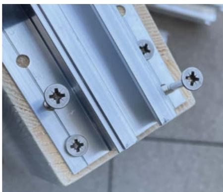
14 Montage der Trägerschienen mit Edelstahlschrauben.
