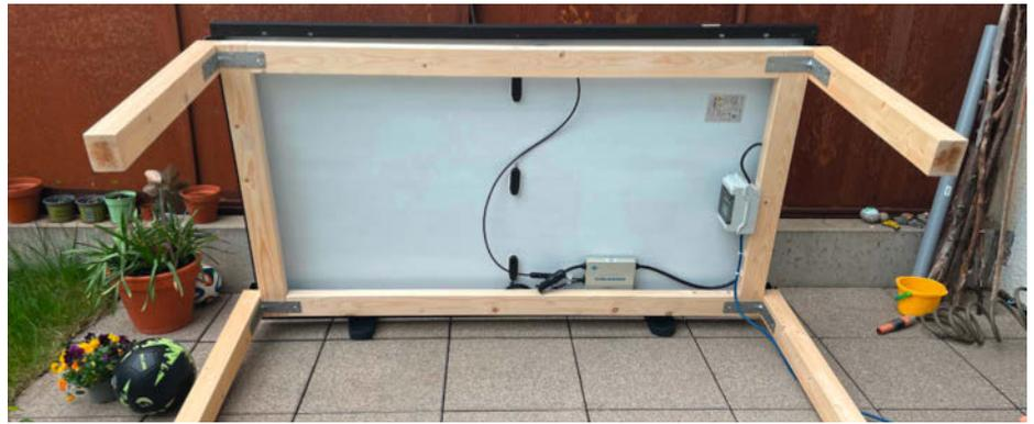
**18** Kabelführung vom MC4-Stecker zum Wechselrichter, dann zum Verteilerkasten
