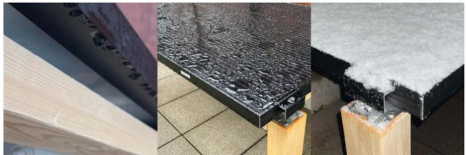
**19** Allwetterfeste Konstruktion des Panels. Das Holz muss behandelt werden.
