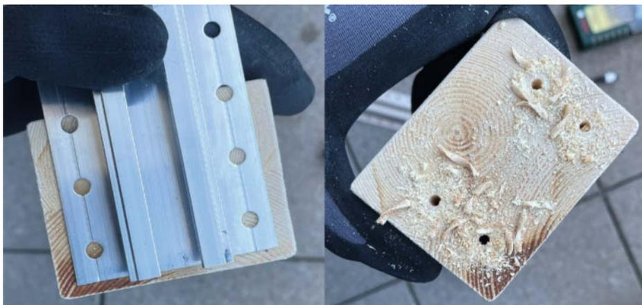
13 Anprobe der Montageschiene, die Positionen für die Holzschrauben unbedingt vorbohren!
