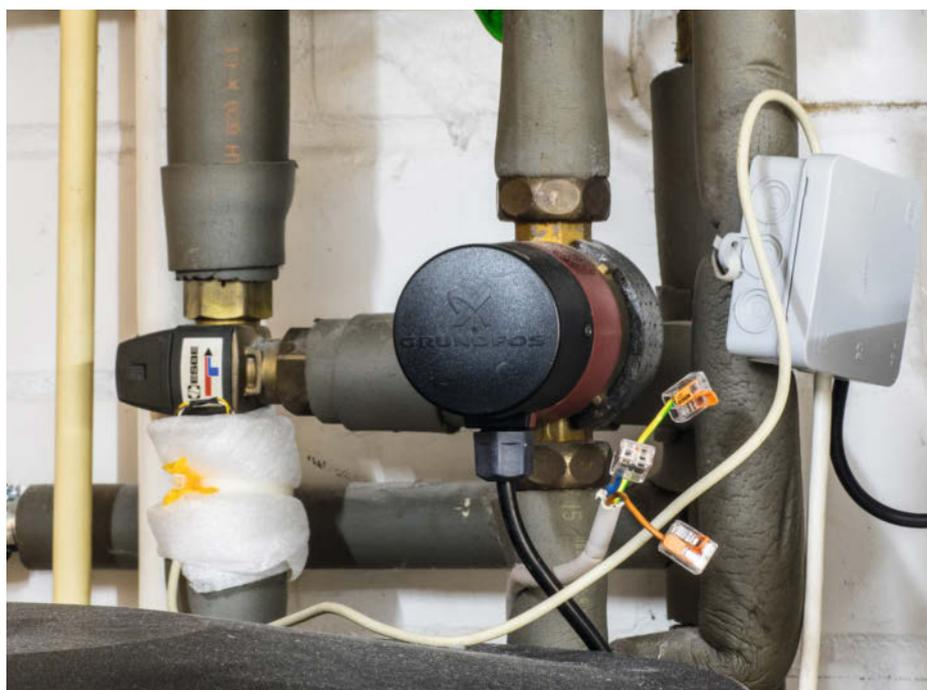
**2** Provisorische Installation an der Heizungsanlage des Autors: Die Schaltung ist in der Verteilerdose untergebracht, links erkennt man die Leitung zum Sensor (hier unter der Isolierung verborgen).
