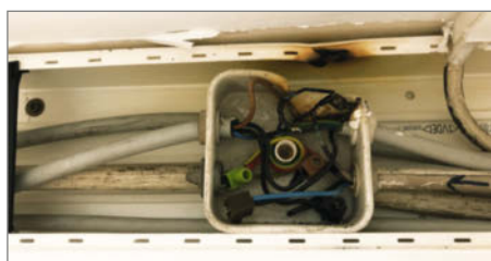
Eine lose Klemme in der Verteilerdose ...
