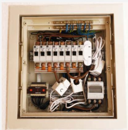
Der Sensor rechts neben den Sicherungen und die drei induktiven Sensoren, die um die dicken braunen Phasenleitungen herum sitzen
