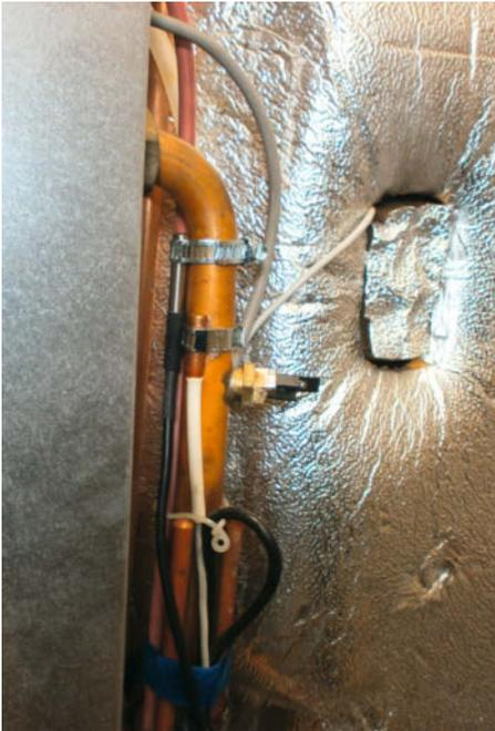
Mit einer angepassten Schlauchschelle ist die Sensorbefestigung kein Problem.
