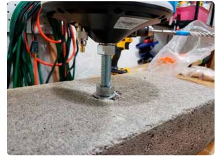
Bild 6. Der Antennenfuß wird auf den Bolzenanker gedreht und mit der Schraube gekontert.
