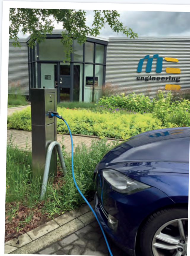
Bild 2. Das Elektroauto von Martin Jepkens lädt an der von ihm selbst gebauten Ladestation vor der Tür des Firmengebäudes von ME Engineering in Marl (Bild: Dr. Thomas Scherer).
