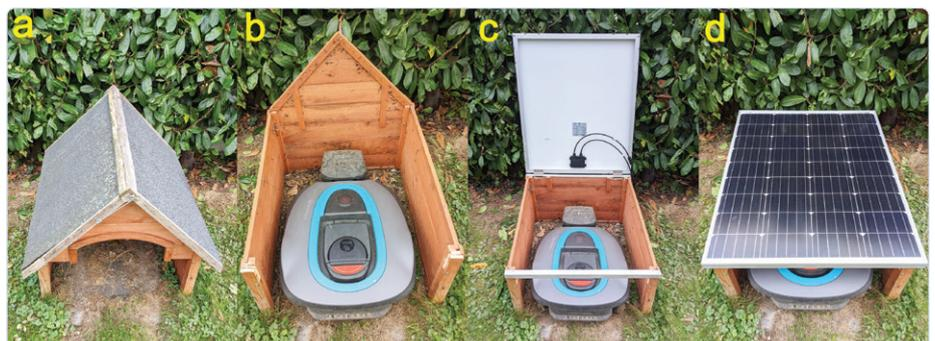
Bild 6. Die vier Stadien des Umbaus einer zweckentfremdeten Hundehütte zur Solargarage für meinen Mähroboter.
