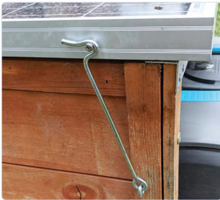
Bild 7. So wird das Panel windsicher arretiert.
