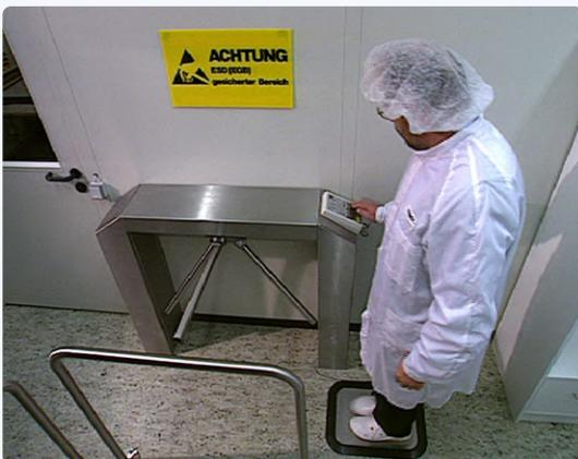
Bild 9. Zutrittschranke zum Produktionskomplex mit ESD-Test.
