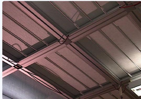
Bild 8. Ionisatoren an der Decke einer Fertigungsanlage.
