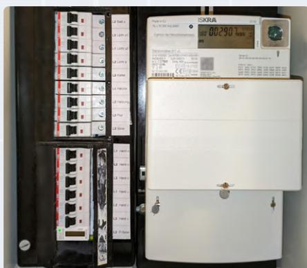
Bild 7. Der Sicherungskasten. Eine zusätzliche 10-A-Sicherung (mittig links) und ein kleiner Stromzähler (unten links) wurden eingebaut. Der moderne Zähler rechts hat eine Rücklaufperre.
