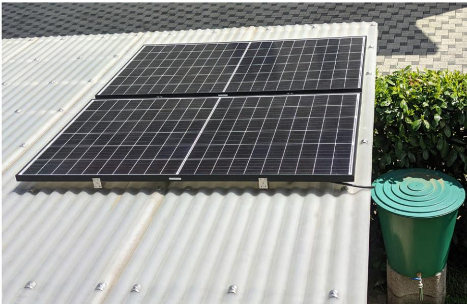
Bild 9. Die beiden 330-Wp-Panels bei der Arbeit auf dem Dach der Veranda.
