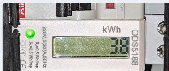
Bild 8. Der preiswerte Extra-Stromzähler erfasst die gesamte, vom Balkonkraftwerk erzeugte Energie. Auf der Anzeige sieht man die Ausbeute des ersten Betriebstages.
