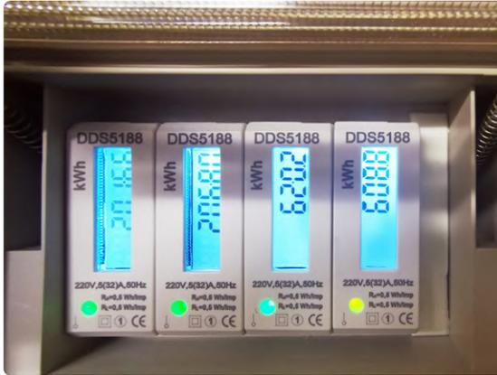
Bild 9. Vier Zähler des Typs DDS5188 im Betrieb.
