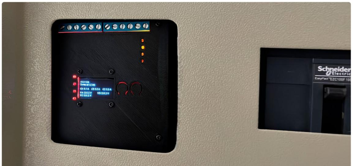
Bild 10. ESP32-Energiemessgerät, installiert in einer Schalttafel zur Überwachung des Stromverbrauchs in Echtzeit.
