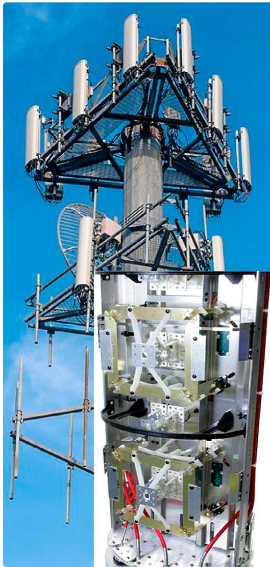
Bild 2. Ein typischer 4G/5G-Turm für die Bänder 700 MHz und 1.800 MHz, mit einer detaillierten Ansicht des Inneren eines Reflektors.
